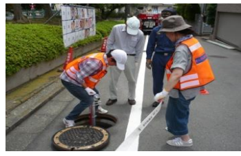
消火栓にスタンドパイプ接続
