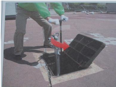
左：スピンドルドライバーを左に（反時計回り）少し回し、水が出るか確認
