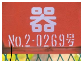
消火器格納箱
