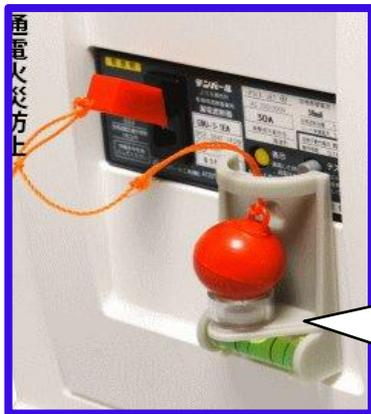
分電盤の主幹ブレーカーのスイッチにおもり玉の付いたひもの先を結びつけ、常時はおもり玉は置台の上に載せておきます。
